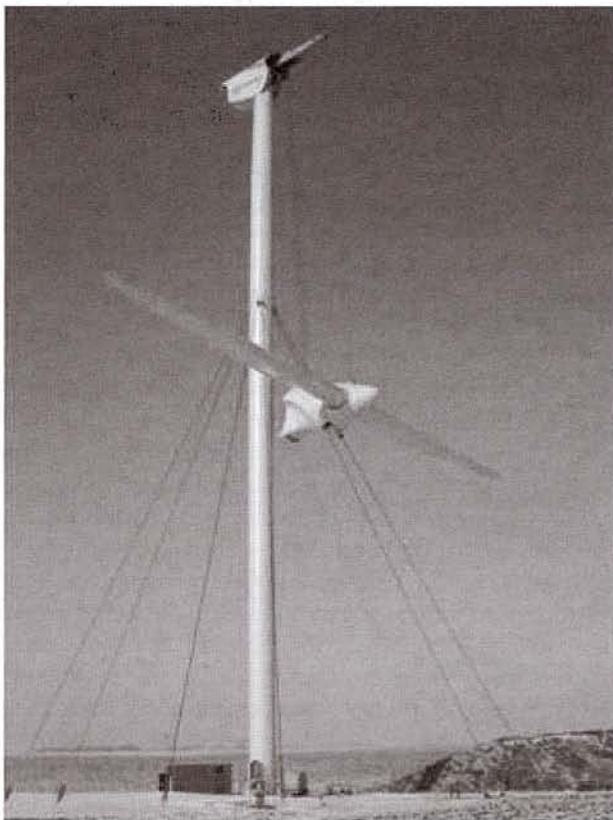
Photo 5 : Eolienne Vergnet GEV HP 1 MW (Source : Vergnet).
